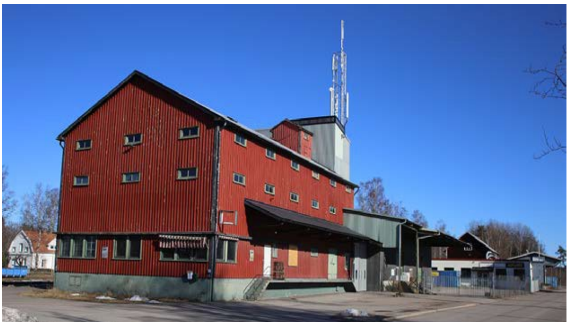
Vy från sydost. Före detta Centralföreningens silobyggnad (Hägern 2).
