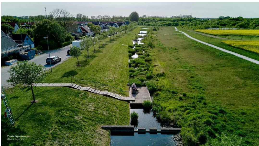
Exempel på gestaltning av Svackdike och översvämningsyta med permanenta vattenspeglar, varierande bottenformer, erosionsskydd i naturmaterial och fuktgynnad vegetation. Källa: Sydväst arkitektur och landskap.
