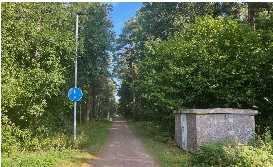
Befintlig gång- och cykelväg i öst-västlig riktning genom skogen, mellan Anderstorpsvägen och centrum, söder om planerad kvartersmark för bostäder.
