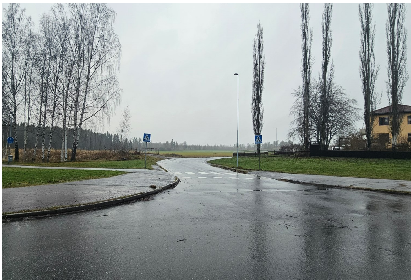
Korsning Anderstorpsvägen och blivande huvudgata (matargata från Häggetorpsleden), vy mot nordväst.
