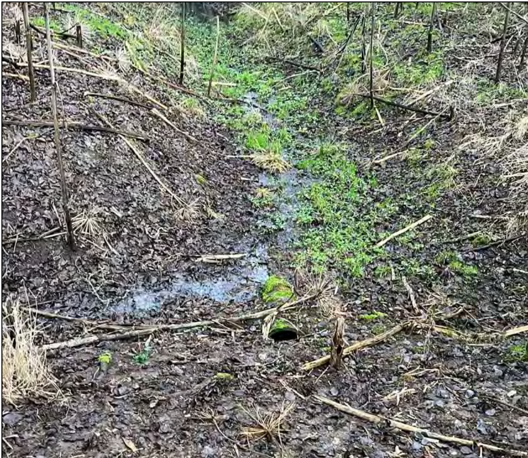
Figur 8. Avställt utlopp från nedlagd avfallsanläggning till bäck.
