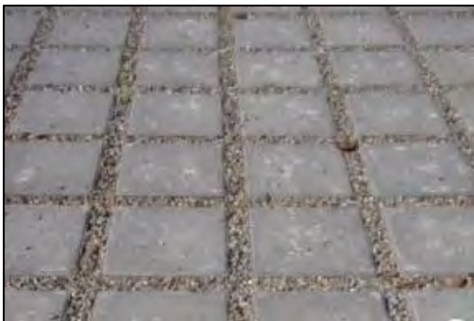
Figur 16. Exempel på genomsläpplig betongbeläggning med grusfogar.
