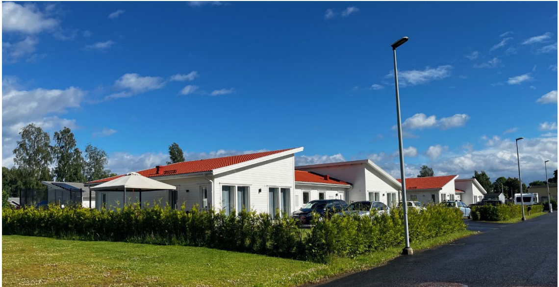
Figur 2: Uppförda parhus på Alten 3 och 4, vy mot sydost.
